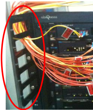
그림 1-6. Cable Duct 설치 및 Cable 정리
