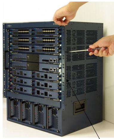
Rack 금속구 R 설치
